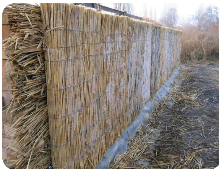
Рис. 11. Для утепления используются камышовые маты, укладываемые в несколько слоев и позволяющие сохранять тепло в теплице более долгое время
