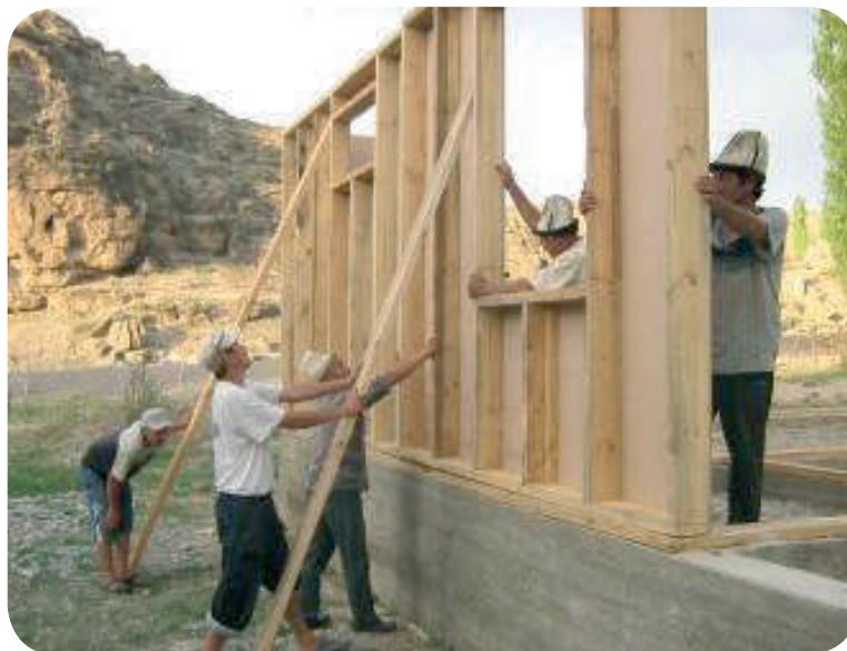
Рис. 28. Технология строительства каркасного дома не требует использования какой-либо тяжелой монтажной техники и большого скопления рабочей силы: стены здания возводятся быстро и легко
