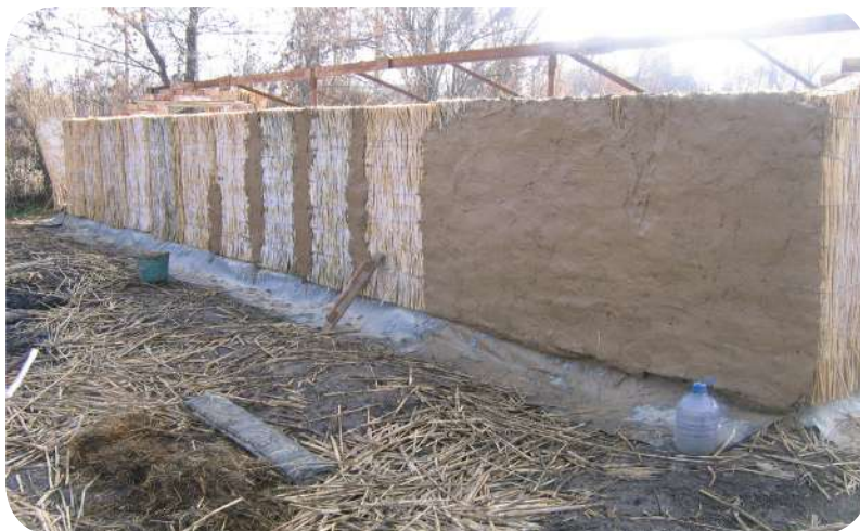
Рис. 10. Поверх камышовых матов накладывается штукатурка, которая повышает продолжительность эксплуатации и эффективность утепления теплиц
