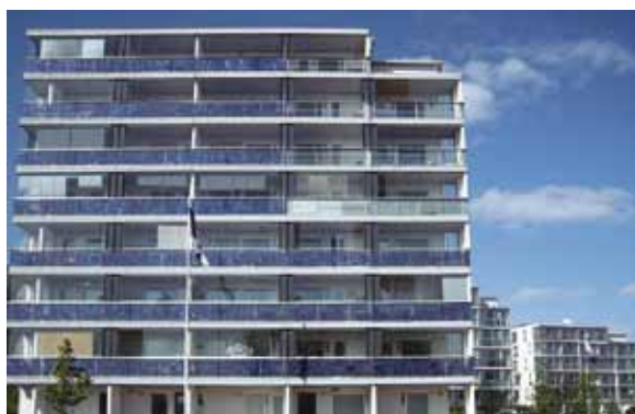
Рис. 3.2.12. Виики – квартал зданий с низкими энергозатратами в Хельсинки (Финляндия). В фасад здания встроены панели, аккумулирующие солнечную энергию.
