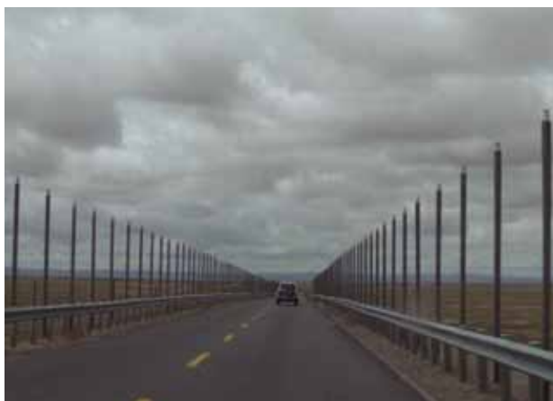
Рис. 2.8.13. Дорога с замораживающими термосифонами.
