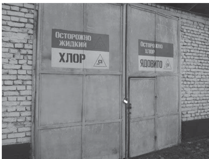
Хранение хлора на водоканале для обработки воды.
