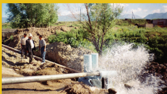
Строительно-монтажные работы спаренных гидротаранов ГТ-400 с плотиной на ручье. Гидротараны в работе.
