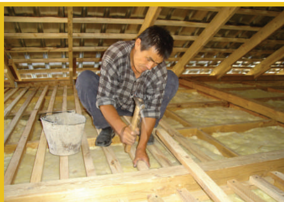
Утепление потолка. СШ Сары Добо, с. Коммуна, Баткенская обл.
