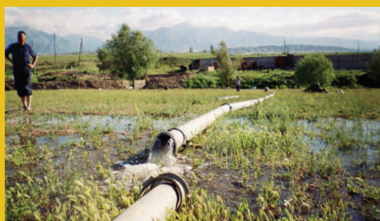
Подъем воды на середину поля на высоту 7 м и выход воды во временный ороситель на высоту 13.5 м
