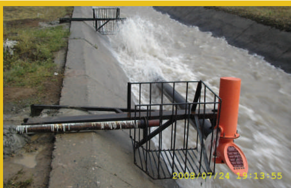
Строительно-монтажные работы спаренных гидротаранов ГТ-400 с плотиной на ручье. Гидротараны в работе.
