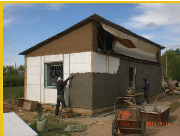
Утепление наружных стен дома пенопластом
