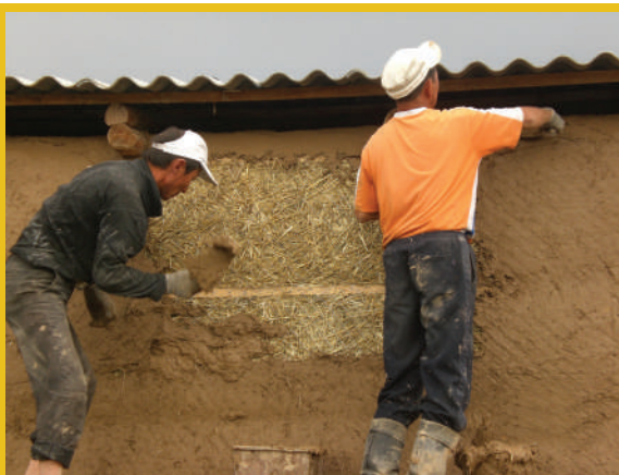
Утепление наружных стен дома с помощью соломы
