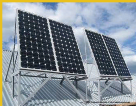
Монтаж солнечных электрических генераторов (фото модулей)
