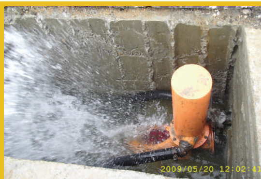
Общий вид гидротарана ГТ-200, установленного на водовыпуске из канала, проходящего по косогору. Корпус гидротарана, установленный в колодце.
