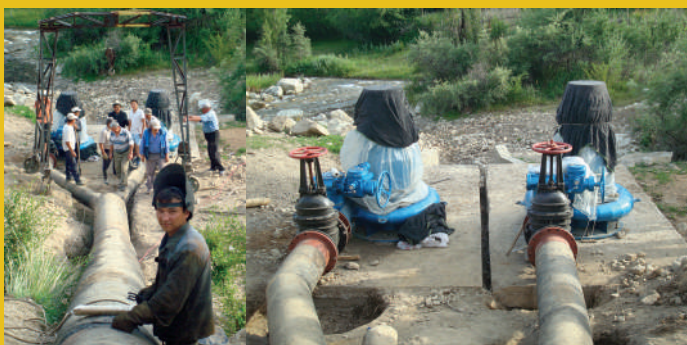
Монтаж малых и микро ГЭС, МГЭС Талды-Суу, Иссык-Кульская обл.
