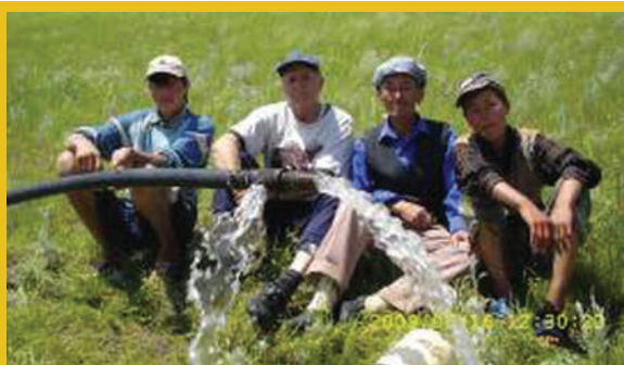
Выход воды через тройник напорного трубопровода на высоту 25 м и орошение при- сельских пастбищ на высоте 30 м.
