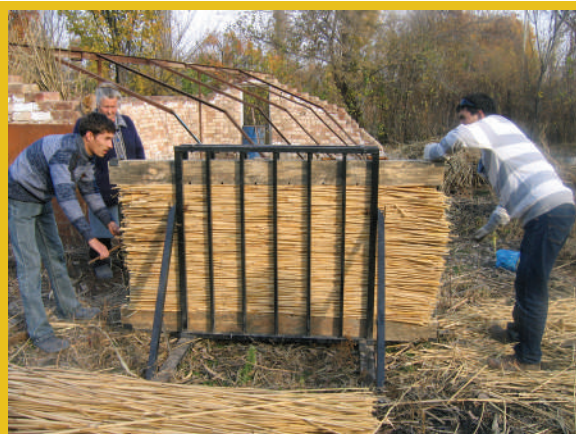
Утепление стен с помощью камышовых матов
