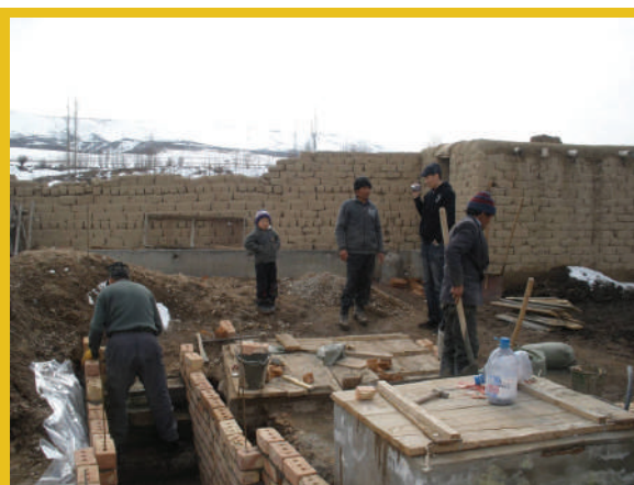
Подготовка места для биогазовой установки
