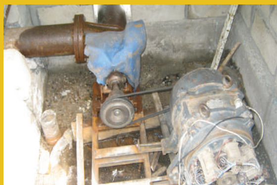
МикроГЭС мощностью 5 кВт в ущелье Чычкан, кафе «Огонек»
