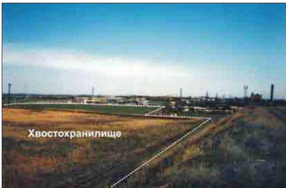
Кара-Балтинское хвостохранилище – после рекультивации
