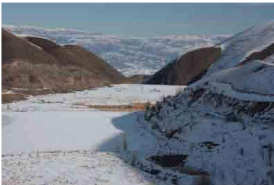
Бурдинское хвостохранилище в районе поселка Орловка
