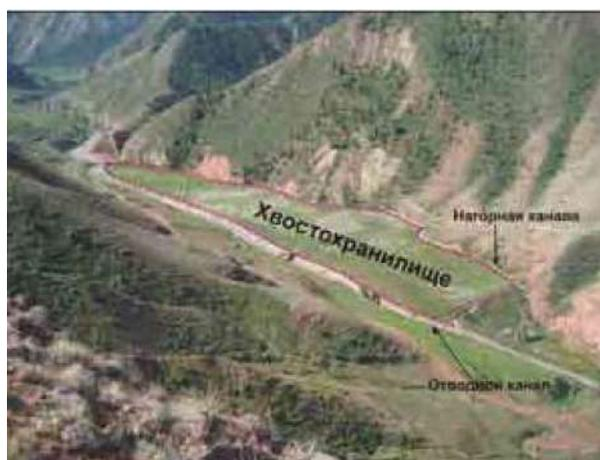
**Хвостохранилище “Туюк-Суу”** расположено в русле одноименной реки. В нем накоплено 450 тыс. м<sup>3</sup> отходов на площади 3,2 га. Для пропуска вод реки построен железобетонный обводной канал.
