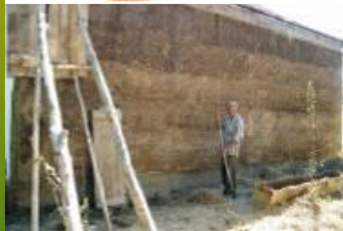
Утепление стен с помощью соломы или камыша (CAMP-Alatoo)
