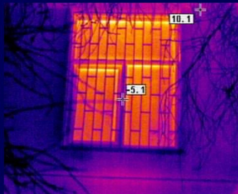
пластиковые окна установленные школой
