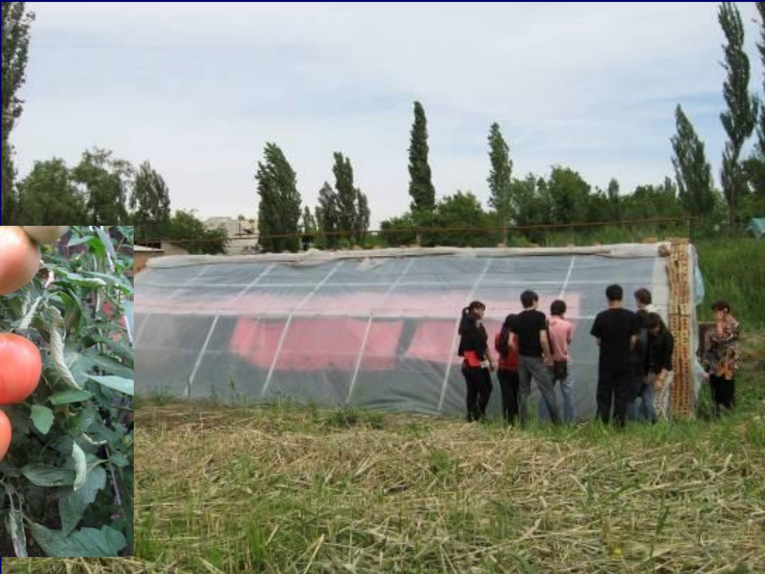
Солнечная улучшенная теплица с.Новопокровка. Чуйская обл.
