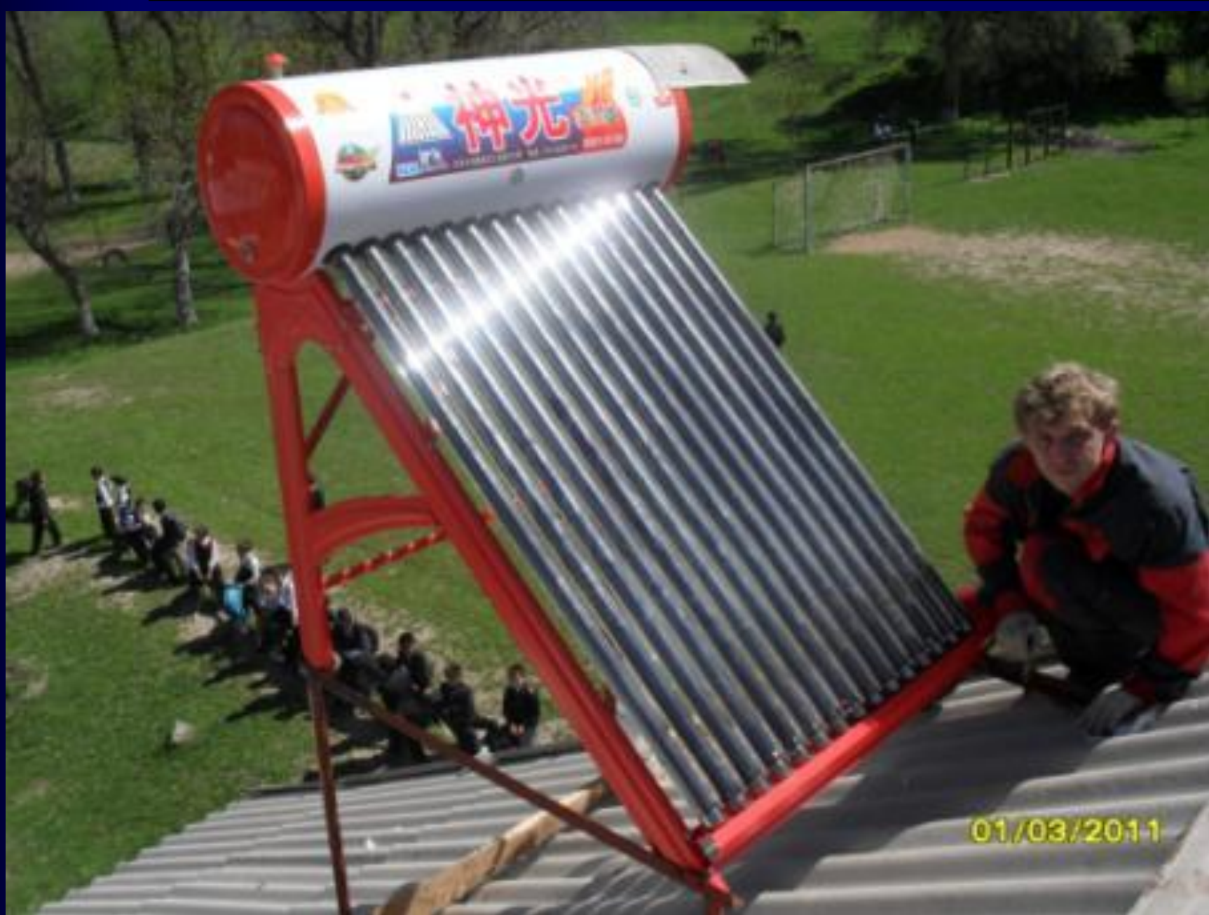
Установка вакуумного коллектора средняя школа с. Бала-Айылчи
