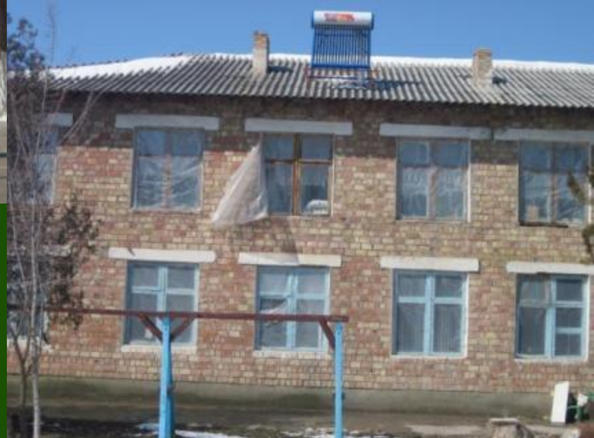
Солнечные вакуумные коллекторы с. Васильевка
